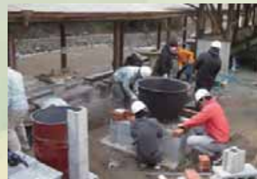
『建設マネジメント実習』における現地施工実習
