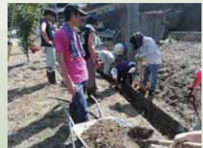
豪雨で使用できなくなった水路の整備
