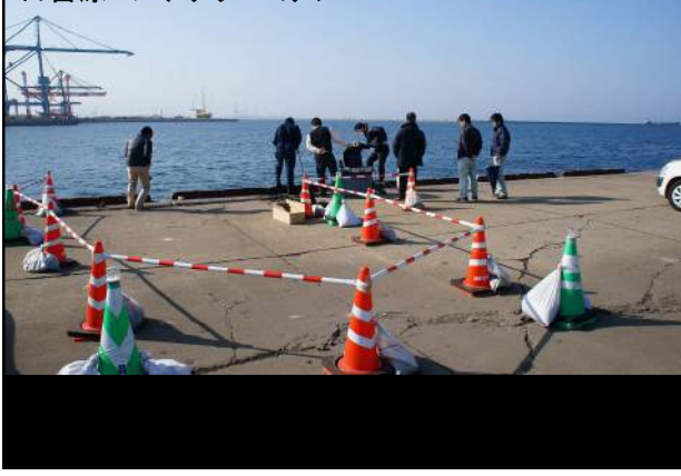
日吉原コンテナターミナル
