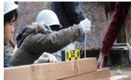
▲「ふるさと体験村」宿泊ケビンの改修作業。
