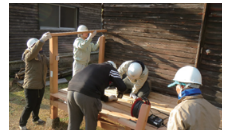
▲建築学科で培った知識でウッドデッキを改修。
