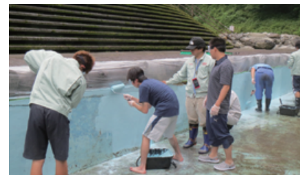
▲河川プールのペンキ塗り。長時間腰を屈めての作業は重労働。
